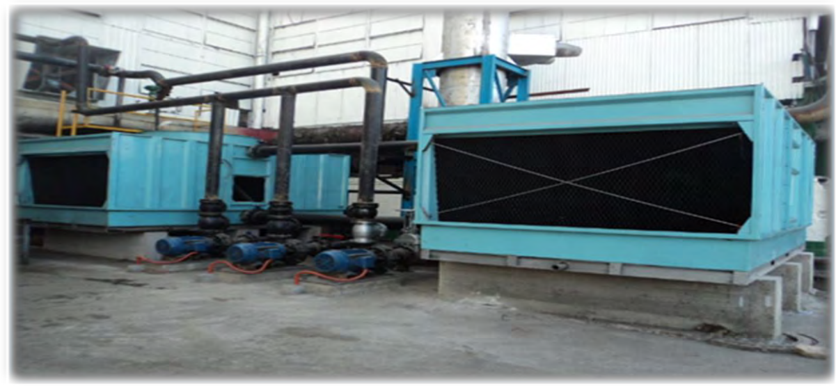
Torre de Enfriamiento N°2
